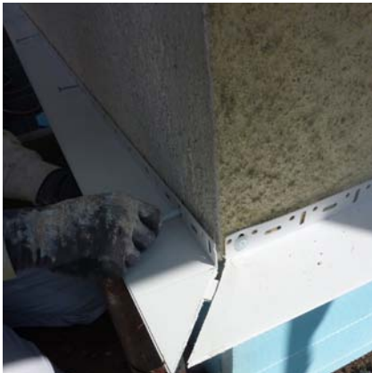
Montage UdiBASE® Wandanschlussprofil
