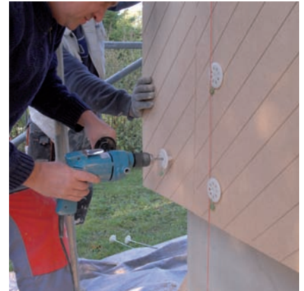
Der Steldübel befestigt und justiert das Dämmelement zugleich
