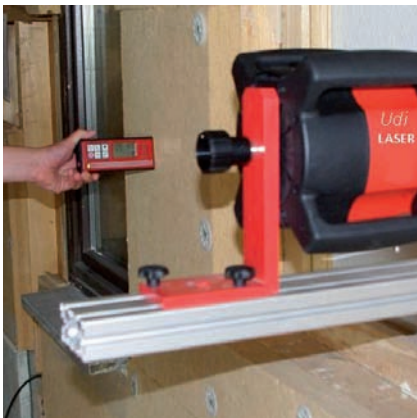
Das Dämmelement kann mit Wasserwaage oder Laser in Lot gebracht werden
