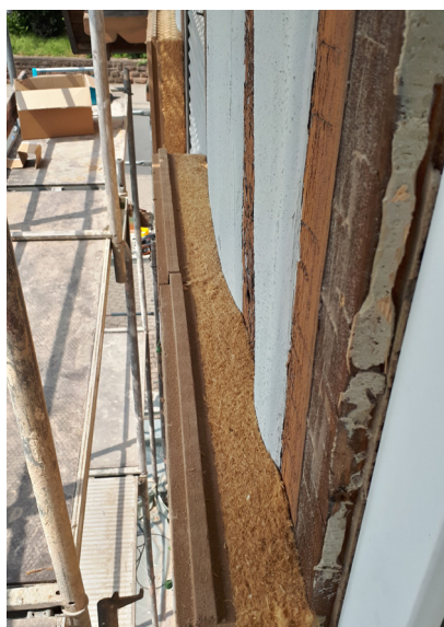
Fachwerkfassaden überdämmen
