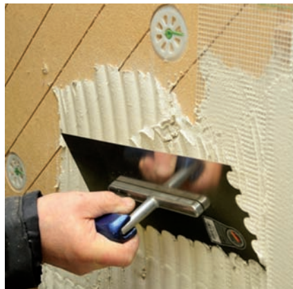
UdiGRUNDSPACHTEL® wird als erste Beschichtung mit rissüberbrückendem UdiARMIERUNG® Gewebe aufgebracht
