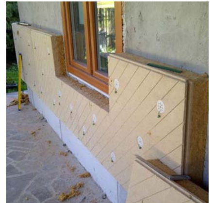
Zuschneid Fensteraussparung und Laibung
