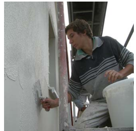
Als Endbeschichtung werden abgestimmte Strukturedelputze aus dem UdiSORTIMENT aufgetragen
