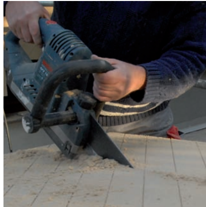
Die Dämmelemente können mit elektrischen Sägen auf die passende Größe zugeschnitten werden
