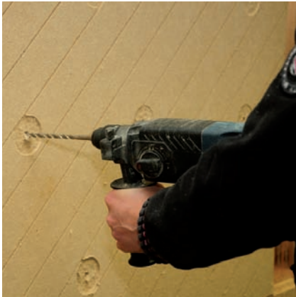
Um den Dübel im Untergrund zu positionieren, wird ein Bohrloch gesetzt
