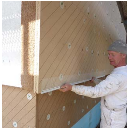
Nach Justierung UdiBASE® Aufsteckprofil aufstecken
